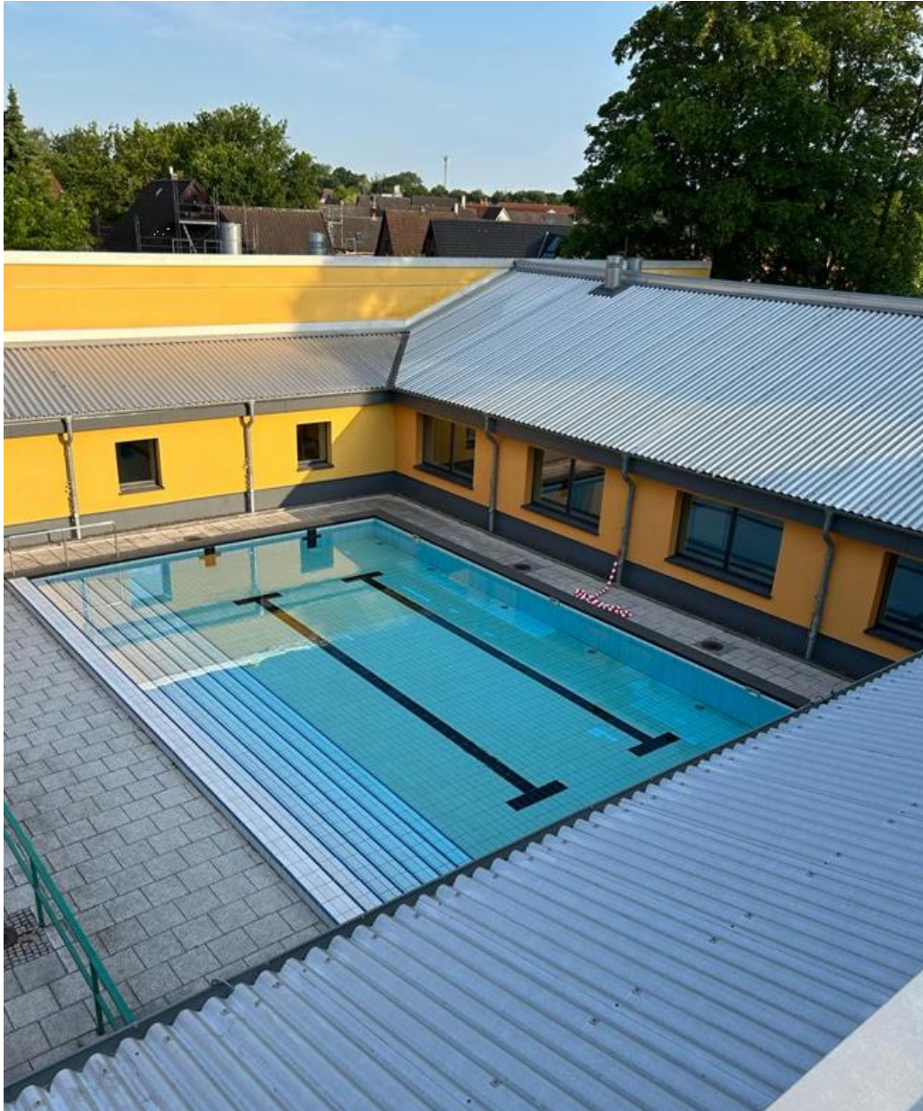
Schwimmbad Stecknitzsschule Berkenthin
