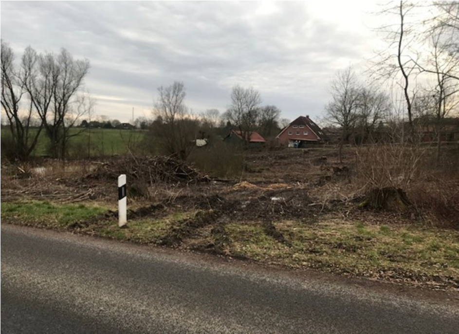
Foto 3: Blick von der Straße in Richtung Hammer: Hier sollte ein Wall aufgeschüttet werden (aus dem Aushub vom Teich).
