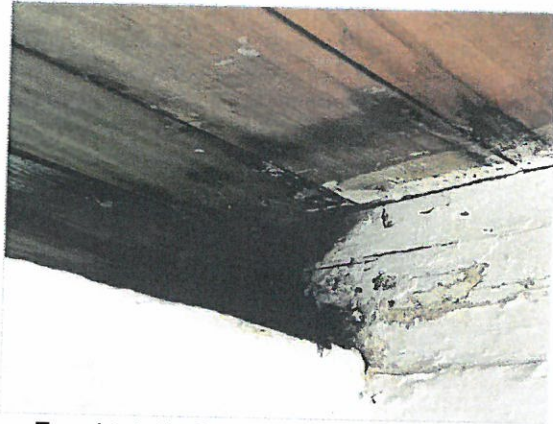
Feuchtstelle Sparren/Dacheindeckung
