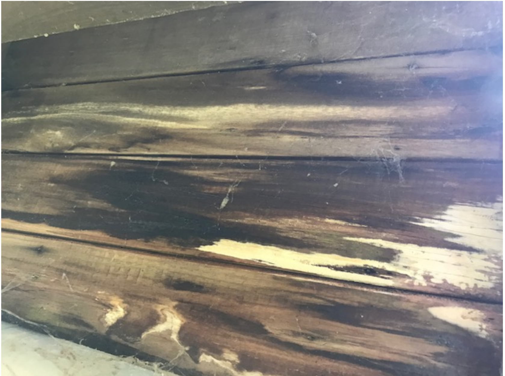
Feuchtstelle Dacheindeckung
