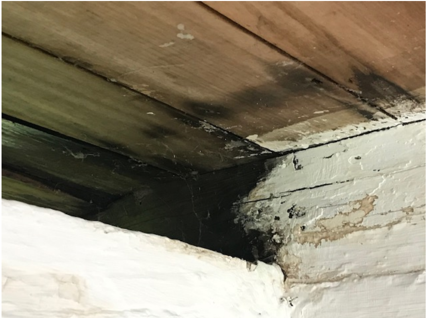
Feuchtstelle Sparren/Dacheindeckung
