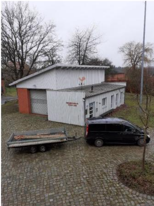
Abb. 4: Feuergerätehaus – Fahrzeughalle und Anbau
